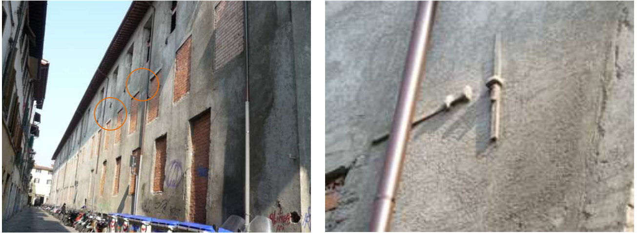
Fig. 5-6: lato lungo via Taddea: dettaglio delle catene.
