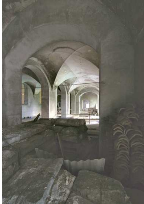
Fig. 11: i locali al piano terra su via S.Orsola
