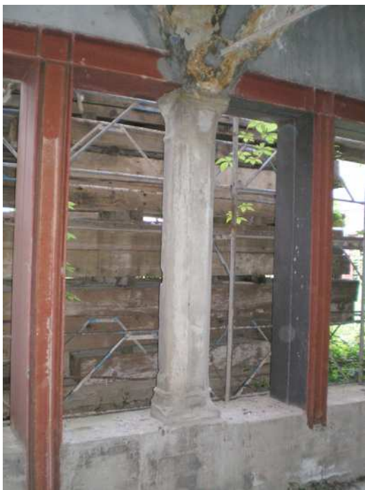
Fig. 1: cortile con colonne a sezione ottagonale
